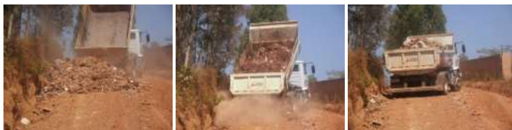
Figura 1. Manutenção de estradas com RCC em Bom Jesus da Penha/MG.
